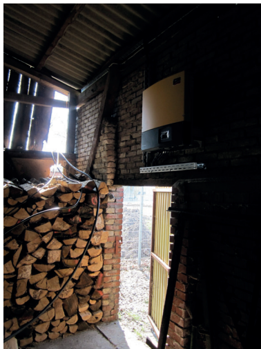
Abb 4.8.8: Unzulässige Montage in „feuergefährdeten Betriebsstätten“, Quelle: VGH Versicherungen
