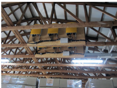
Abb 4.8.8: Unzulässige Montage in „feuergefährdeten Betriebsstätten“, Quelle: VGH Versicherungen
