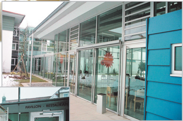
Fassade aus Stahl und Glas
