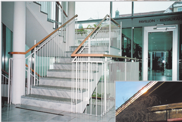
Geländer- und Treppenbau
