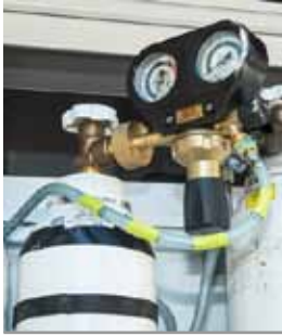
Abb. 1: Bei Gasflaschen ist der Druck in bar auf der Druckskala ablesbar.
