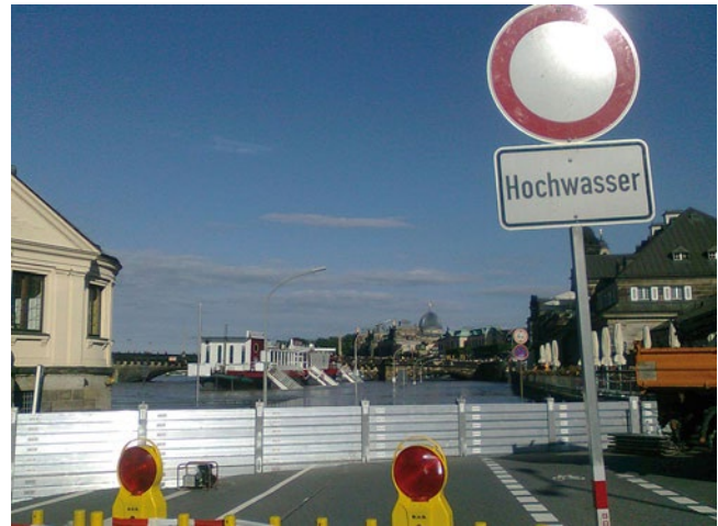
Abb. 2.1 Hochwasser und Einsatz von Hochwasserschutzwänden in Dresden, 2013 (Foto: Cindy Sturm)
