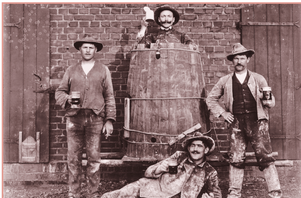
Bierbacchanten in Oberaden: Grabungsarbeiter feiern die Freilegung eines römischen Weinfasses im Lippischen Land (Foto um 1910).
