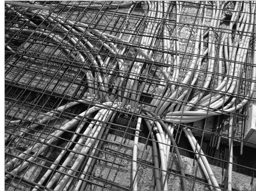
Abbildung 17.1 Leerrohre vor dem Gießen der Betondecke
