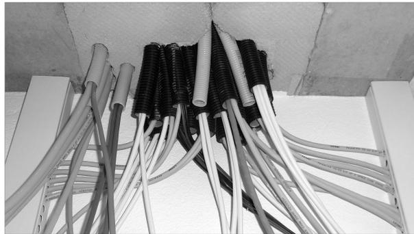
Abbildung 21.1 Sternförmige Verkabelung zu einem 19-Zoll-Rack
