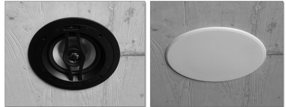
Abbildung 40.2 Lautsprecher in Betondecke mit und ohne Gitter
