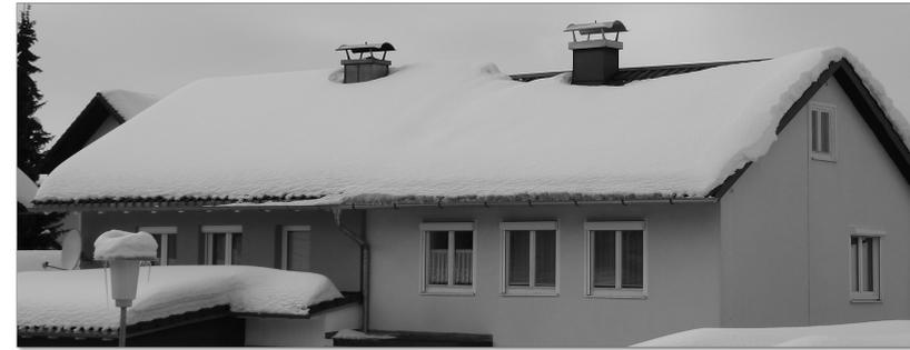
Abbildung 2.1 Doppelhaushälften mit weniger Dämmung (rechts) und mit mehr Dämmung (links)
