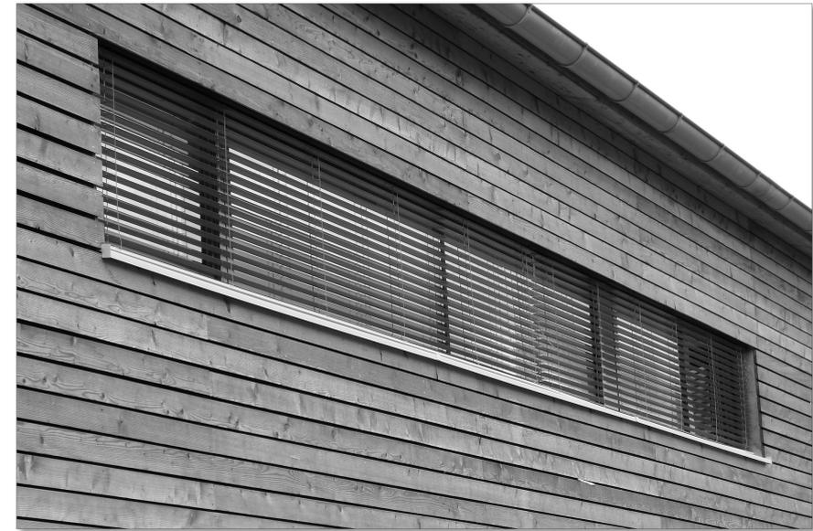
Abbildung 3.2 Außenjalousien, in die Gebäudesteuerung integriert
