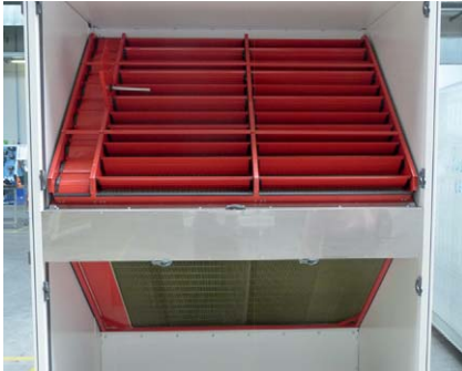
Abb. 2.11 und 2.12 Bypasslösung (jeweils links in den Abbildungen) zur Regelung der Wärmeübertragungsleistung bei einem Plattenwärmeübertrager (Quelle: M. Stahl)
