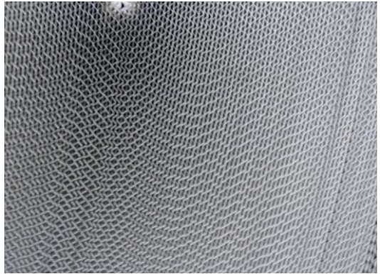
Abb. 2.13 und 2.14 Einsatz eines Rotationswärmeübertragers in einem RLT-Gerät (links) und rechts ein Detail der Rotorwicklung aus dünnen glatten und gewellten Aluminiumfolien/-blechen (Quelle: M. Stahl)
