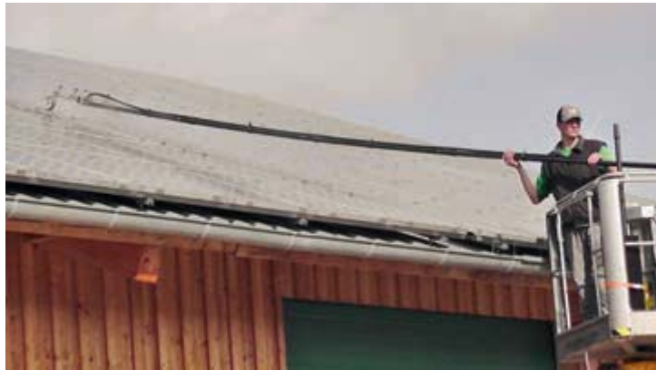
Abb. 3.4.22/3: Handgeführtes Düsenmodul (Quelle: B & W Solar Solutions)
