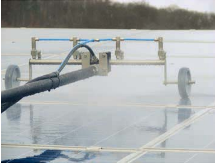
Abb. 3.4.22/2: Berührungslose Technik im Einsatz – Reinigungsschlitten (Quelle: B & W Solar Solutions)
