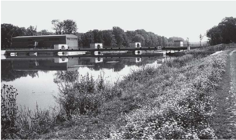
Abb. 6.8: Vorbildlich angelegte Böschung mit Böschungsweg beim Donau-Kraftwerk Dillingen (Foto: Rhein-Main-Donau AG)
