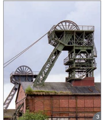
Schachtanlage Deutlich ist die Seilumschlingung, ca. 130^\circ , zu erkennen. © reel – Fotolia.com
