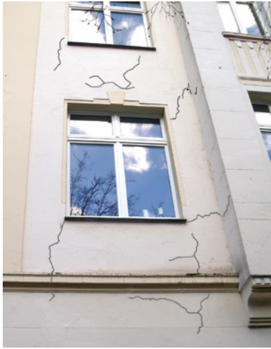
Abb. 4.12: Typische Rissbildungen im Fensterbereich und an auskragenden Bauteilen (Risse zur Verdeutlichung nachgezeichnet)
