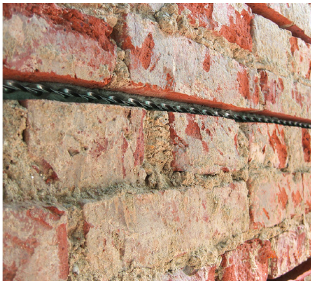
Abb. 4.16: Eingebaute Spiralanker (Quelle: Rubersteinwerk GmbH, Lichtenstein)
