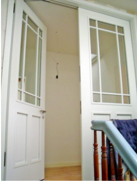
Abb. 7.3: Neue Wohnungseingangstür mit Rauchschutz – angelehnt an die Gestaltung der bestehenden Wohnungseingangstüren des Hauses
