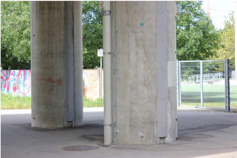
**Bild 4.5** Geteilte Rundstütze eines integralen Mehrfeldrahmens
