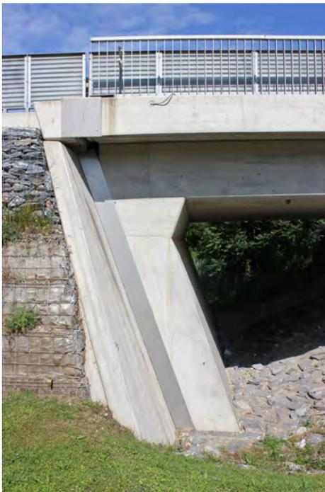
**Bild 4.3** Ausführung eines flexiblen Widerlagers mit Weicheinlage
