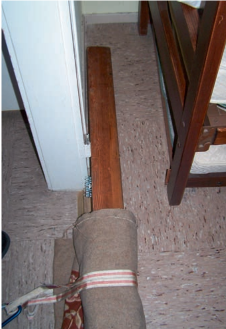
Abbildung 22: Anschlagpunkt im Bereich eines Türrahmens (Foto: Werft)
