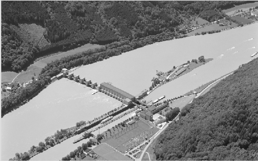
Abb. 4.3 Staustufe Jochenstein / Donau in Österreich. Links im Bild das geschlossene Wehr, daneben das Kraftwerk und eine Doppelschleuse
