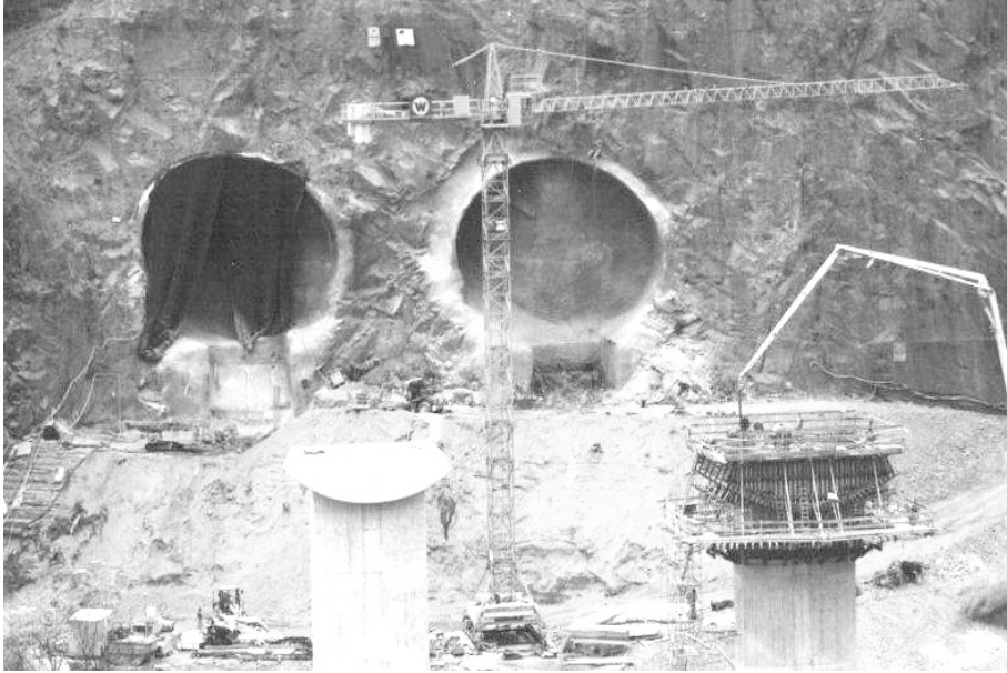
Abb. 5.4: Ausbruch Tunnel Coschütz 2002 (Quelle: Autobahnamt Sachsen)
