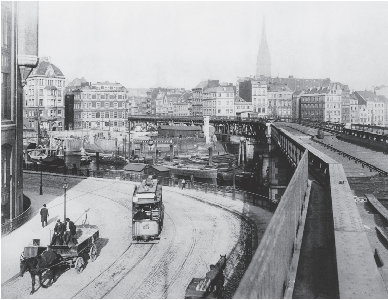
April 1912: Am Baumwall ist die neue Hochbahn fast fertig
